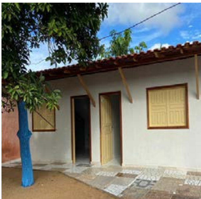
Espaço após a conclusão das obras.
