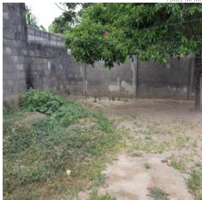
Local não contava com estrutura adequada
